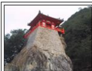
修復工事の終わった阿伏免観音
