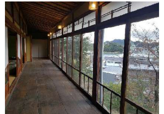
▲約15m、一枚板の間松の床板
